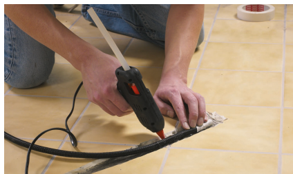
7. Фиксация гофротрубки
