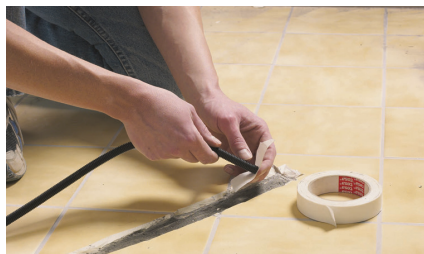
6. Необходимо заглушить отверстие в гофротрубке любым подходящим способом
