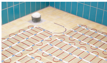
11. Продолжение укладки мата
