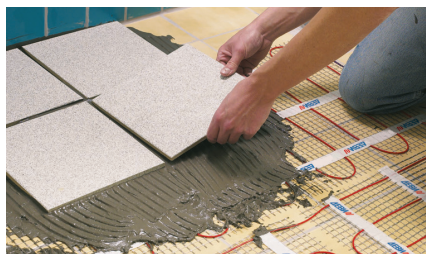
13. Установка плитки*
