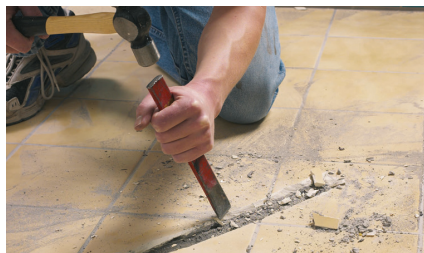
5. Штробление канала и установка гофротрубки для датчика
