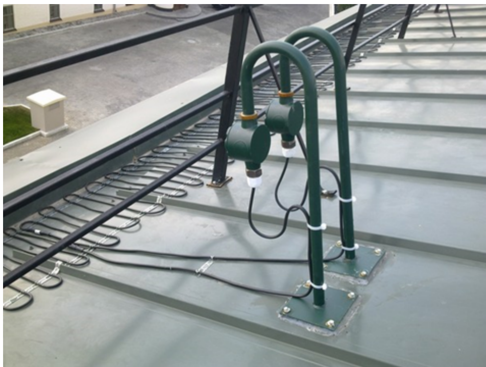
Рис. 3. Монтаж нагревательного кабеля на крыше.DEVIsnow™ 30T
