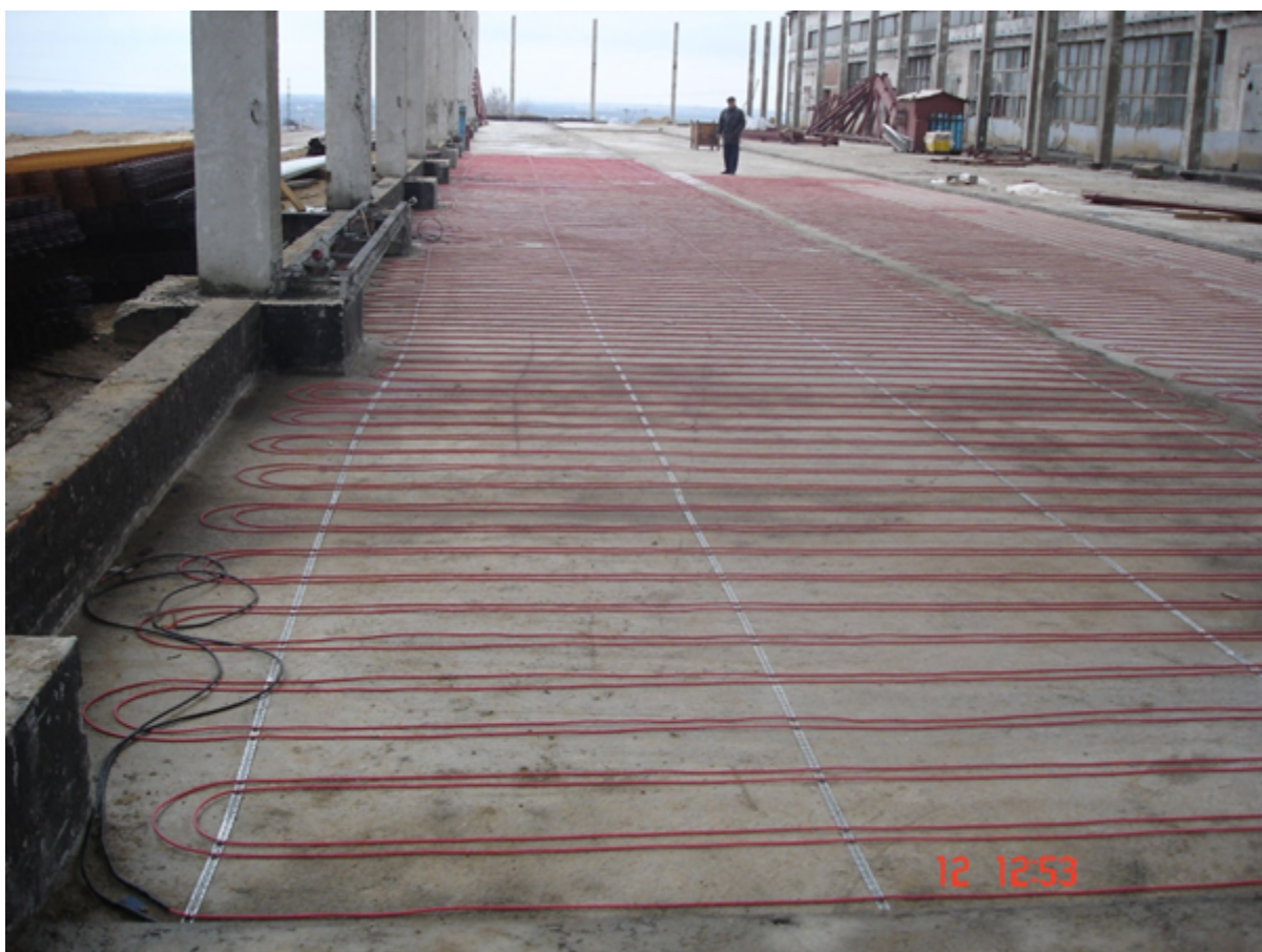
Рис. 5. Монтаж нагревательного кабеля DEVIbasic™ 10S для подогрева грунта под холодильной камерой.
