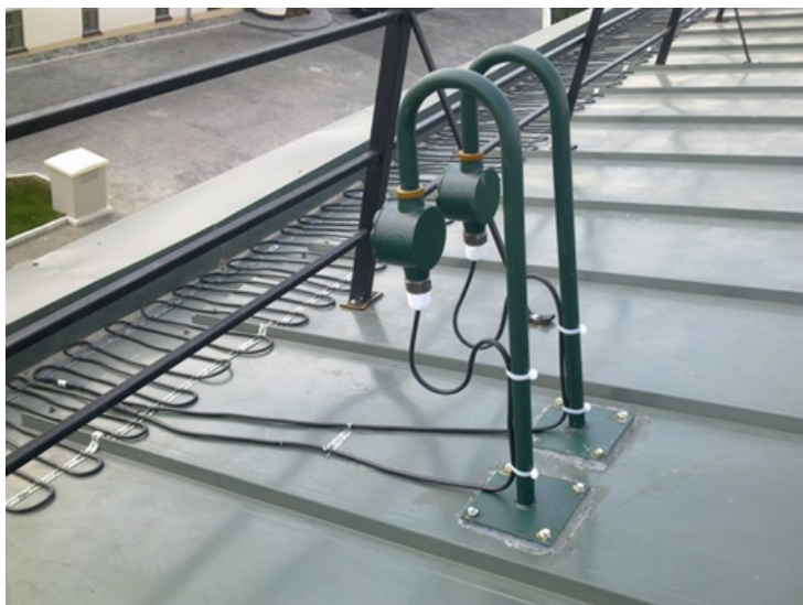
Рис. 3. Монтаж нагревательного кабеля на крыше. ДЕВИ Snow-30Т
