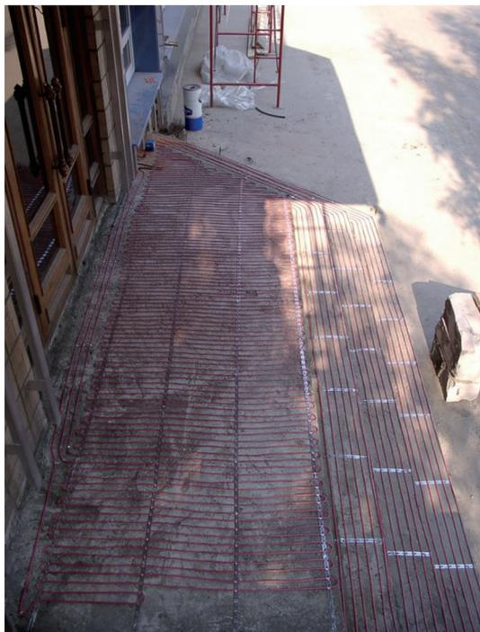
**Фото 3.** Монтаж системы снеготаяния на крыльце.
