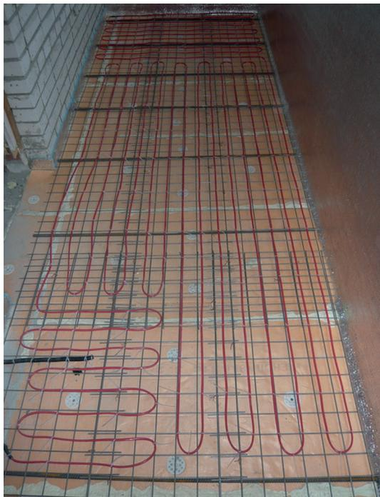
**Фото 1.** Монтаж теплого пола на утепленном балконе.
