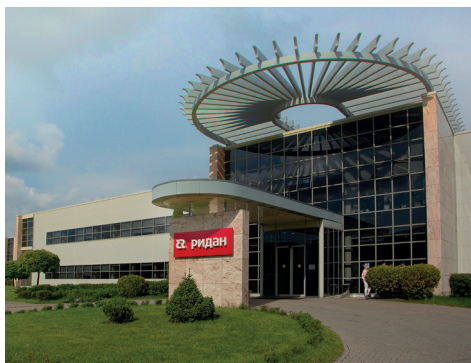
Офисно-производственная площадка компании «Ридан Трейд» в Лешково, МО
