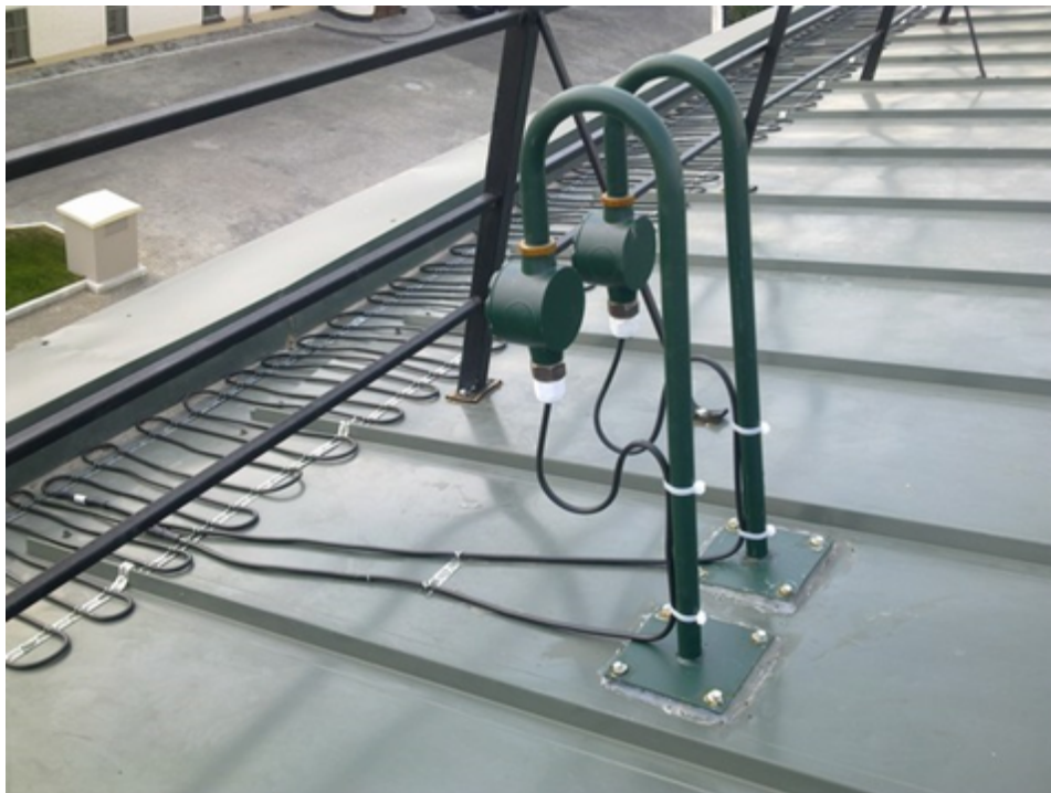
Рис. 3. Монтаж нагревательного кабеля ДЕВИ Snow-30Т на крыше.
