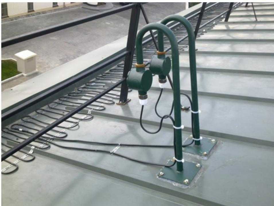
Рис. 3. Монтаж нагревательного кабеля на крыше. DEVIsnow™ 30T
