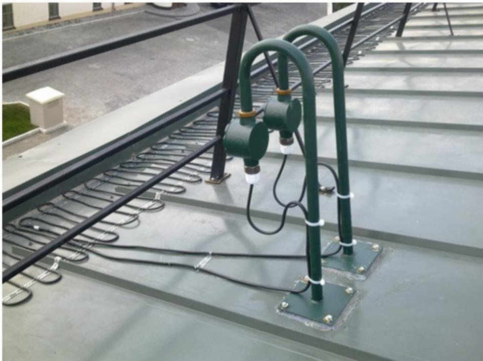
Уклон кровли в зоне расположения настенного жёлоба небольшой. Это требует обогрева достаточно широкой полосы кровли у стенки жёлоба, 40...60 см и более. В данном случае нагревательный кабель уложен змейкой на двух полосках монтажной ленты с шагом укладки 7,5 см. Обычно кабель с линейной мощностью 30 Вт/м укладывается с шагом 7,5...10 см, что обеспечивает удельную мощность обогрева соответственно 400...300 Вт/м<sup>2</sup>.
