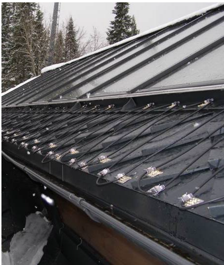
Край металлической кровли с подвесным жёлобом.
