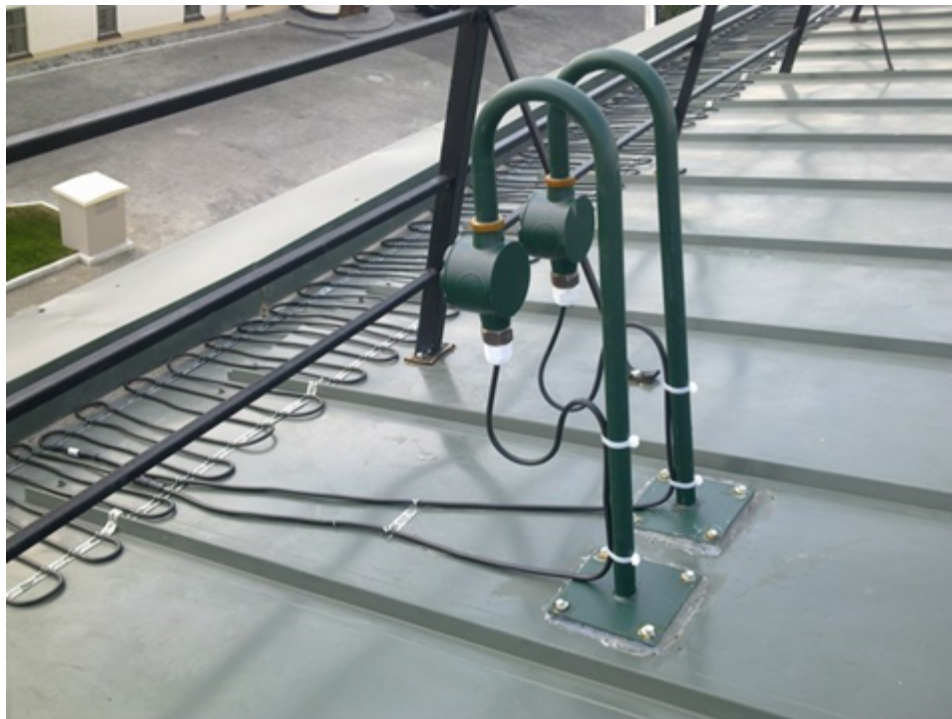
Рис. 3. Монтаж нагревательного кабеля ДЕВИ Snow-30Т на крыше.
