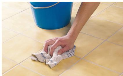
4. Подготовка поверхности, удаление пыли. Поверхность цементно-песчаной стяжки под наклейку мата необходимо загрунтовать. Сетка мата имеет клеевую основу, однако для максимального эффекта пол должен быть очищен от грязи и пыли.
