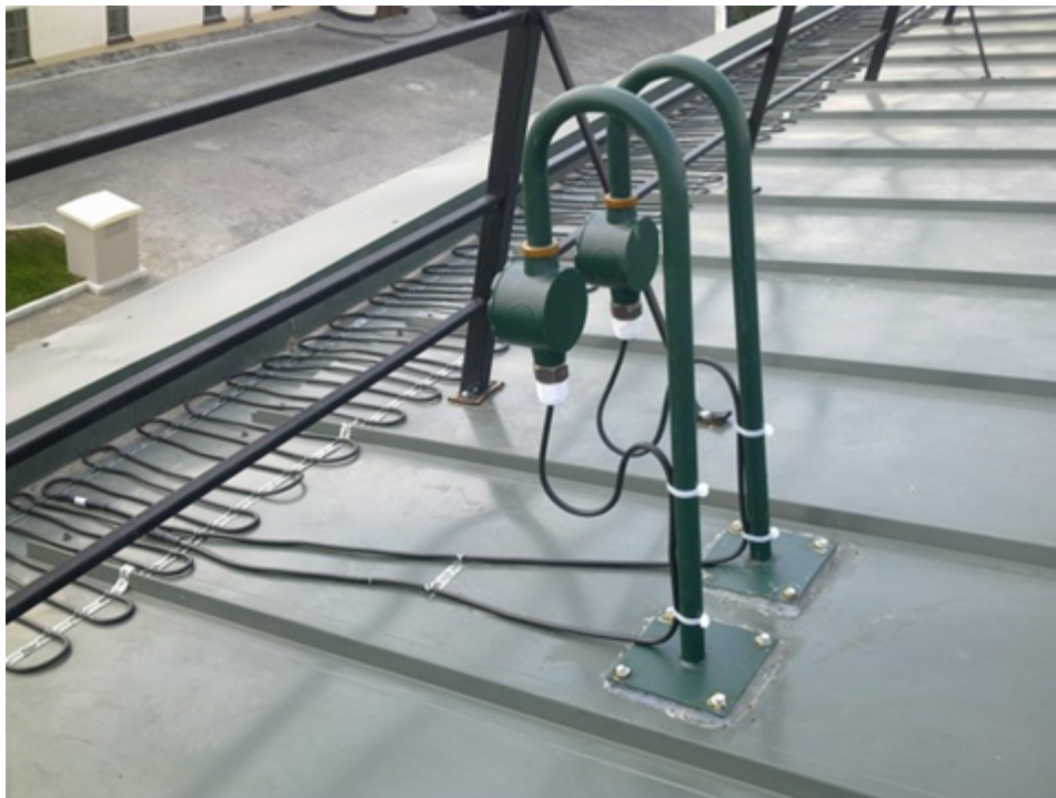
Рис. 3. Монтаж нагревательного кабеля ДЕВИ Snow-30Т на крыше.
