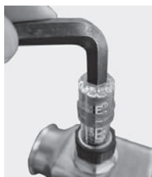
Закрывать расходомер и открутить колбу ключом
