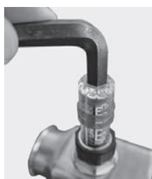
Закрыть расходомер и открутить колбу ключом
