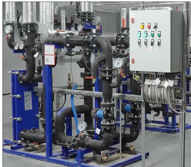
Рис. 2. Пример теплового пункта блочного исполнения с оборудованием, приборами и устройствами «Ридан».
