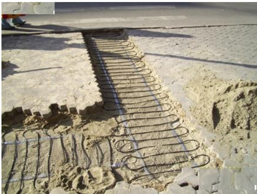
Рис. 4. Монтаж нагревательного кабеля ДЕВИ Snow-30Т для обогрева пешеходной зоны.
