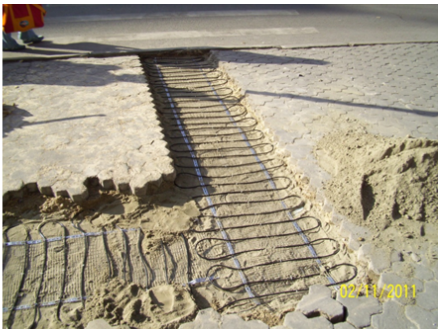
Рис. 4. Монтаж нагревательного кабеля DEVIsnow™ 30T для обогрева пешеходной зоны.
